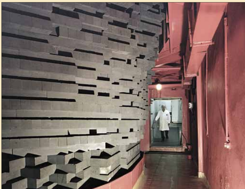
Здание «монтажных мастерских» и графитовая кладка реактора Ф-1 сегодня.
